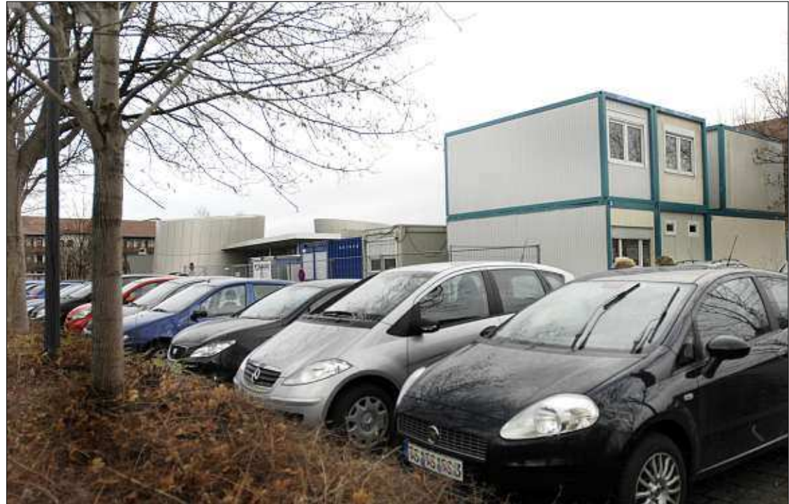
Containeraufstellung für die Interimsnothilfe: Ab Sonntagabend und bis zum Mittwoch wird sich die Parkplatzsituation an der Kreisklinik Altötting schwierig gestalten. – Foto: Willmerdinger
